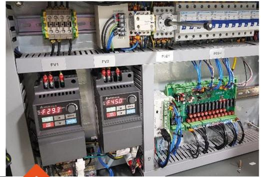
Système de contrôle de PLC avec carte I/O PCB et le convoyeur d'inverseur/entraînement et le contrôle de moteur de bosse.
